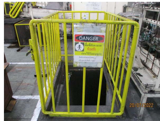
รูปที่ 2-18 บ่อคอนกรีตเก็บน้ำปนเปื้อนน้ำมันใต้เครื่องทุบขึ้นรูป
