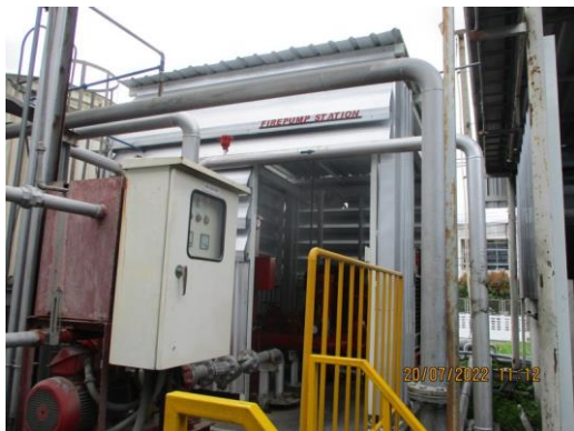
รูปที่ 2-57 ดำเนินการติดตั้งวัสดุกันเสียงครอบปิดคลุมเครื่องสูบน้ำของ Cooling Tower และเครื่องสูบน้ำดับเพลิง
