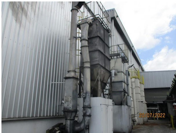
รูปที่ 2-37 ระบบบำบัดมลพิษทางอากาศแบบถุงกรอง ของเครื่องขัดผิวชิ้นงาน
